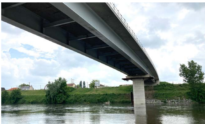
La digue provisoire a été entièrement démontée et les matériaux d'emprunts rendus à la rivière.
