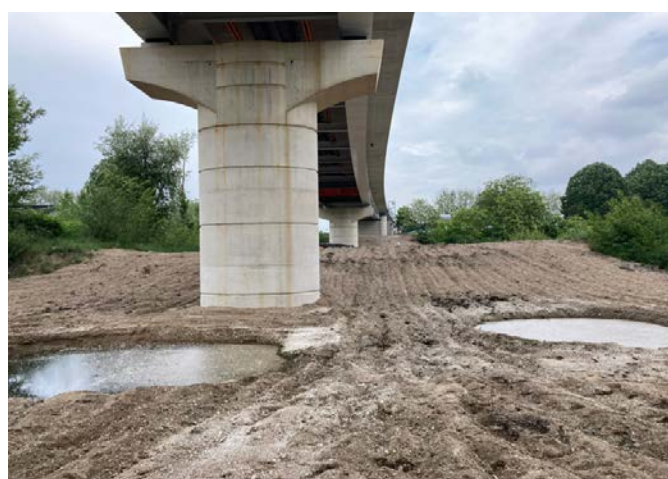
Mares. Trois mares ont été aménagées, sous le deuxième pont, dans le cadre des mesures compensatoires.
