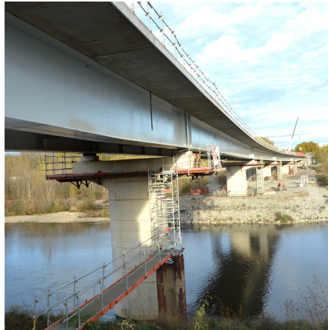
Ci dessus le pont en rive gauche, en cours de jonction avec la culée qui reliera ensuite l'ouvrage aux voies de circulation.
