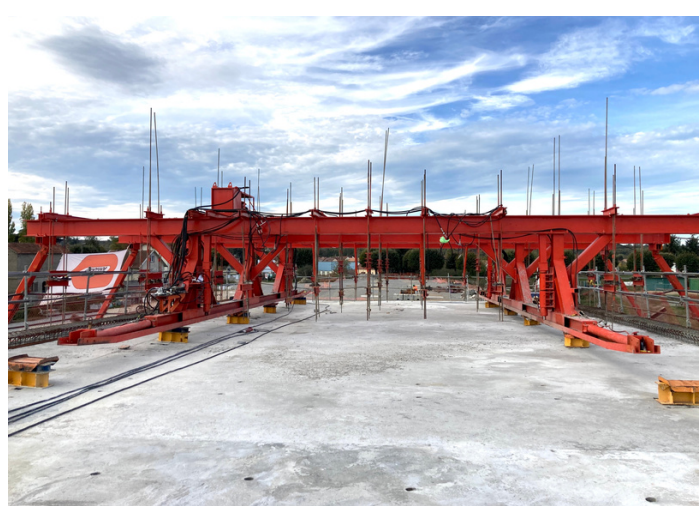
L'équipage mobile se déplace durant le bétonnage du tablier de l'ouvrage principal.
