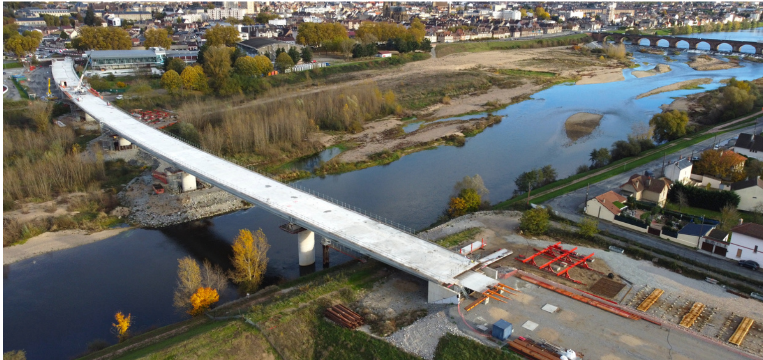
Ci dessus le pont en rive gauche, en cours de jonction avec la culée qui reliera ensuite l'ouvrage aux voies de circulation.
