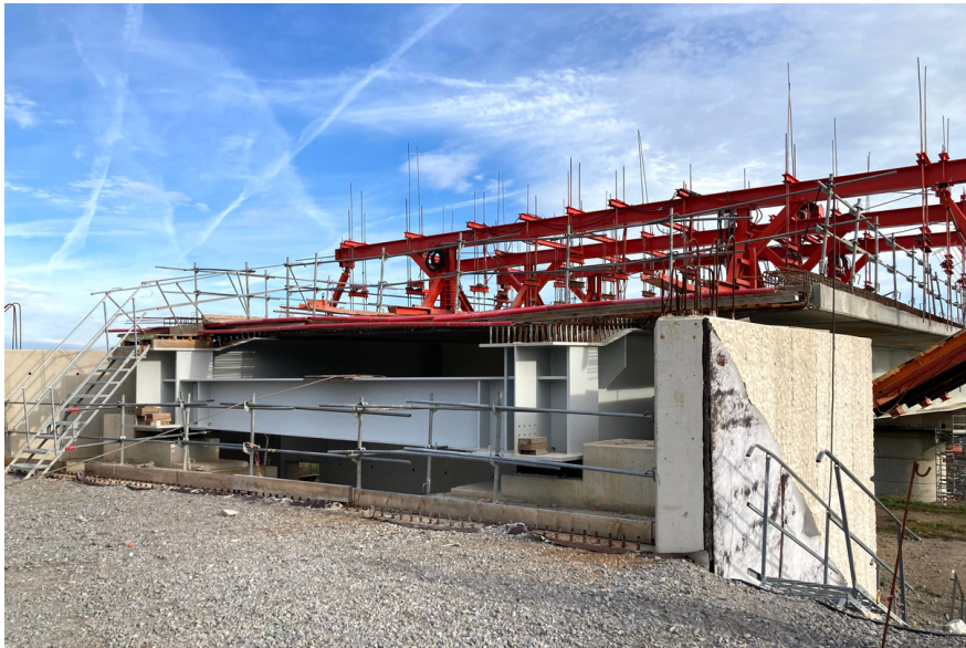
Ci dessus le pont en rive gauche, en cours de jonction avec la culée qui reliera ensuite l'ouvrage aux voies de circulation.
