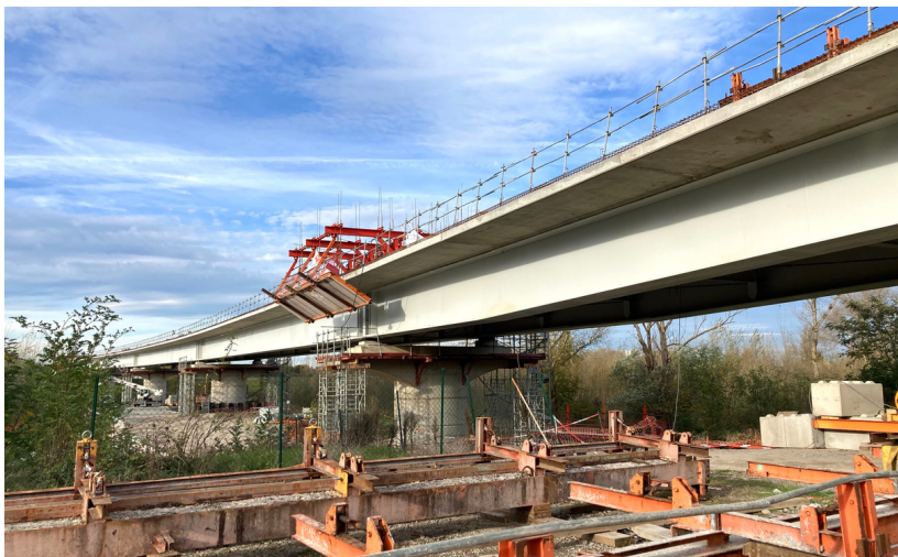
L'équipage mobile se déplace durant le bétonnage du tablier de l'ouvrage principal.
