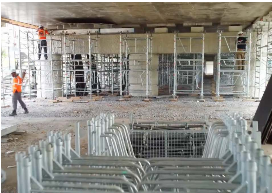
Démontage de l'échafaudage sur l'ouvrage secondaire, parking de l'Oive. Cette partie inférieure du pont est désormais terminée
