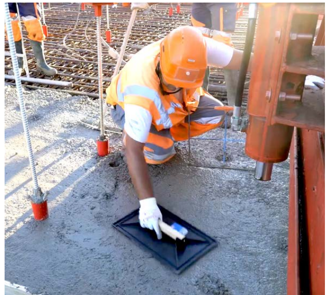
Réalisation du tablier de l'ouvrage principal à l'aide d'un équipement mobile
