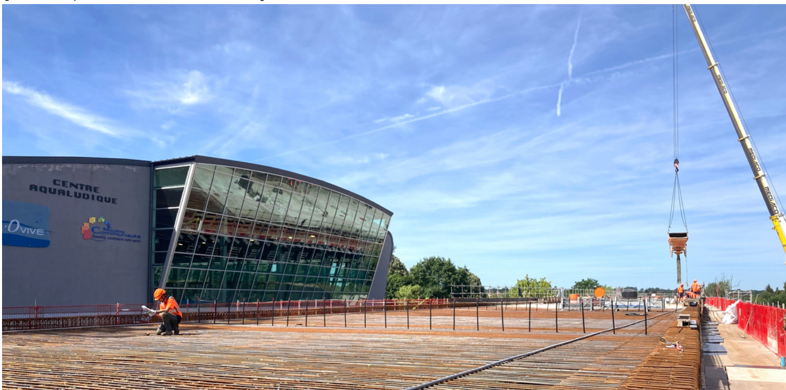
Ferraillage de la dernière partie du tablier de l'ouvrage secondaire. La dernière des quatre phases de bétonnage du tablier de l'ouvrage secondaire a été réalisée le 23 juin.
