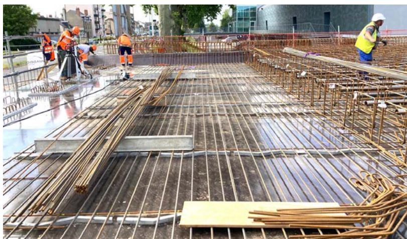
Ferraillage de la dernière partie du tablier de l'ouvrage secondaire. La dernière des quatre phases de bétonnage du tablier de l'ouvrage secondaire a été réalisée le 23 juin.
