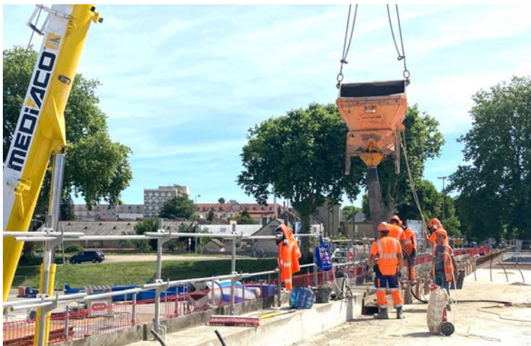
Bétonnage des poutres longitudinales qui vont accueillir les garde corps des deux côtés de l'ouvrage.
