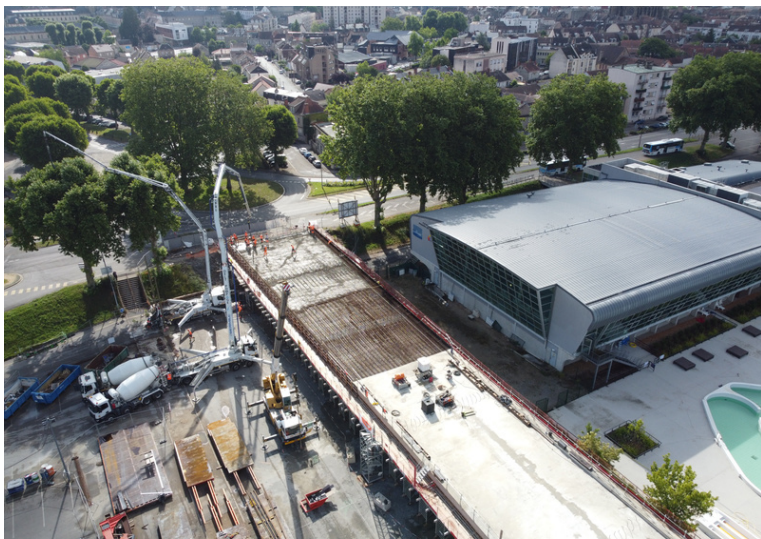
Bétonnage des poutres longitudinales qui vont accueillir les garde corps des deux côtés de l'ouvrage.
