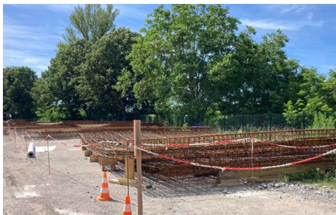
Les paillasse métalliques ont été assemblées. Elles seront installées à l'intérieur du tablier de l'ouvrage principal, avant le coulage du béton.
