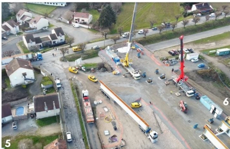
Photo 3 : Convoi exceptionnel sur le pont Régemortes, fermé durant quelques minutes pour permettre le passage, l'un après l'autre, des camions chargés de poutres métalliques d'une cinquantaine de tonnes. Photo 4 et 5 : Arrivée des poutres sur le chantier rive gauche, où elles sont assemblées pour former la charpente du pont.
