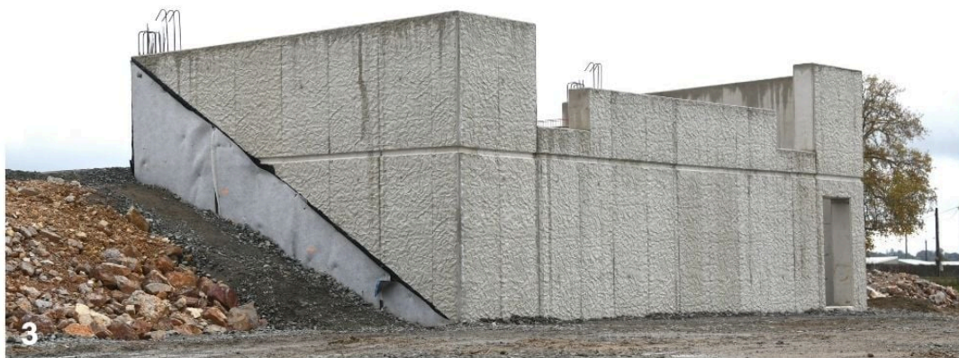
Photo 5 : Mise en place des batardeaux pour les piles suivantes, sur la digue provisoire de la rive droite.
