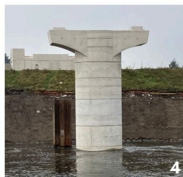
Photo 4 : Le batardeau de la première pile a été enlevé progressivement
