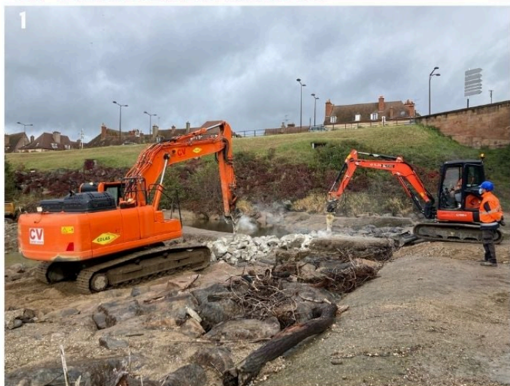
Photo 1 : Démolition de l'ancienne passe à poissons.
