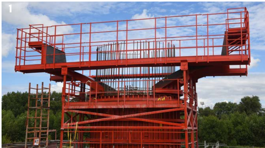
Photos 1, 2 et 3 : Préparation et assemblage du gigantesque coffrage à l'intérieur duquel le béton de la première pile est coulé.
