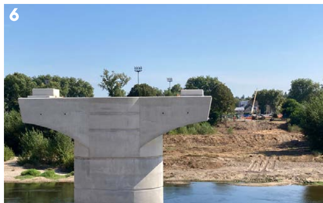
Photos 3, 4 et 5. Après un temps de séchage, le coffrage est retiré et la première pile, terminée, apparaît. La digue provisoire est en cours de déconstruction. Une nouvelle digue va être créée sur l'autre rive pour la suite du chantier.
