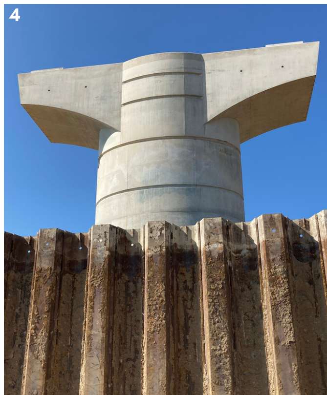
Photos 3, 4 et 5. Après un temps de séchage, le coffrage est retiré et la première pile, terminée, apparaît. La digue provisoire est en cours de déconstruction. Une nouvelle digue va être créée sur l'autre rive pour la suite du chantier.
