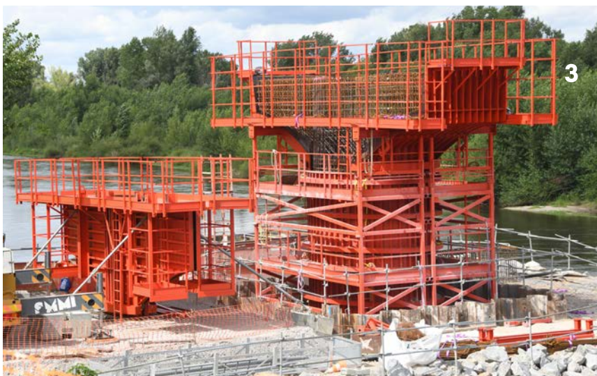
Photos 1, 2 et 3 : Préparation et assemblage du gigantesque coffrage à l'intérieur duquel le béton de la première pile est coulé.
