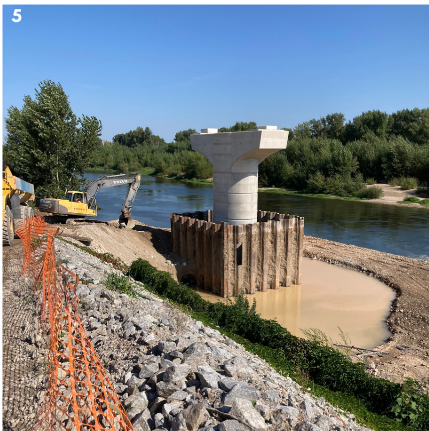
Photos 3, 4 et 5. Après un temps de séchage, le coffrage est retiré et la première pile, terminée, apparaît. La digue provisoire est en cours de déconstruction. Une nouvelle digue va être créée sur l'autre rive pour la suite du chantier.
