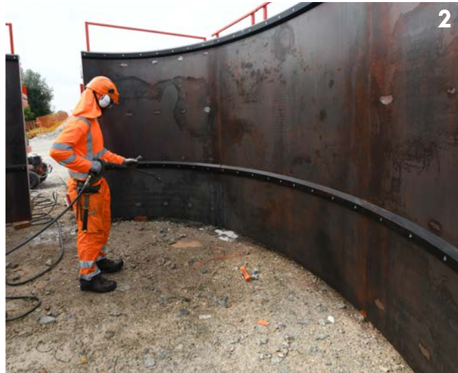
Photos 1, 2 et 3 : Préparation et assemblage du gigantesque coffrage à l'intérieur duquel le béton de la première pile est coulé.
