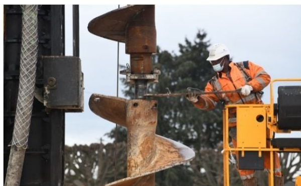
Intervention de la foreuse avant la mise en place des armatures (en haut à droite) et montage de la "tarière", l'outil capable de creuser les roches les plus dures. Mars 2021
