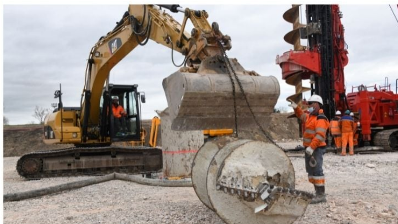
Intervention de la foreuse avant la mise en place des armatures (en haut à droite) et montage de la "tarière", l'outil capable de creuser les roches les plus dures. Mars 2021
